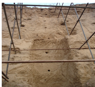
图 3 开挖前的边坡
